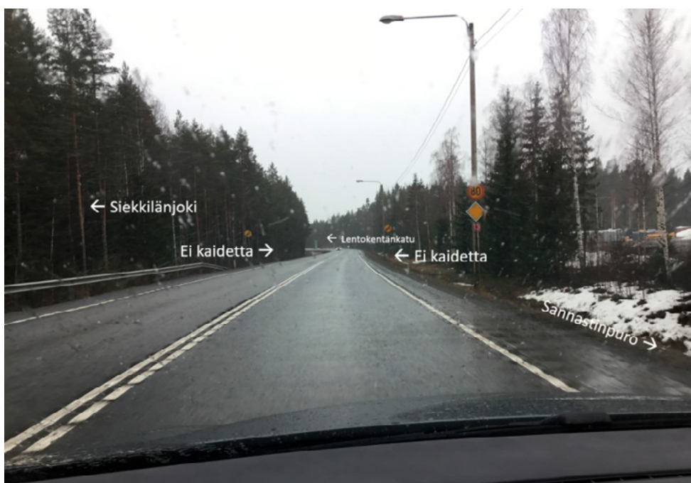
Kuva 67. Jyväskylälentien Lentokentänkadun liittymän ja Savilahdenkadun eritasoliittymän välillä ei ole kaiteita, vaikka tie sijaitsee penkereellä.
