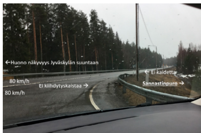
Kuva 64. Savilahdenkadun eritasoliittymä. Ajoneuvo liittymässä Jyväskylälle. Ei kiihdytyskaistaa tai kaiteita ja Sannastinpuroon on suora yhteys.
